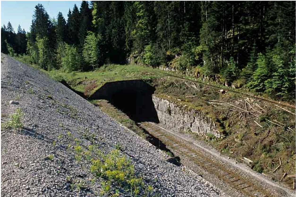
Vue plongeante sur la tête côté Andelot-en-Montagne (nord-ouest).
