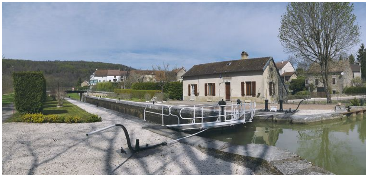
Vue d'ensemble de l'amont du site d'écluse.
