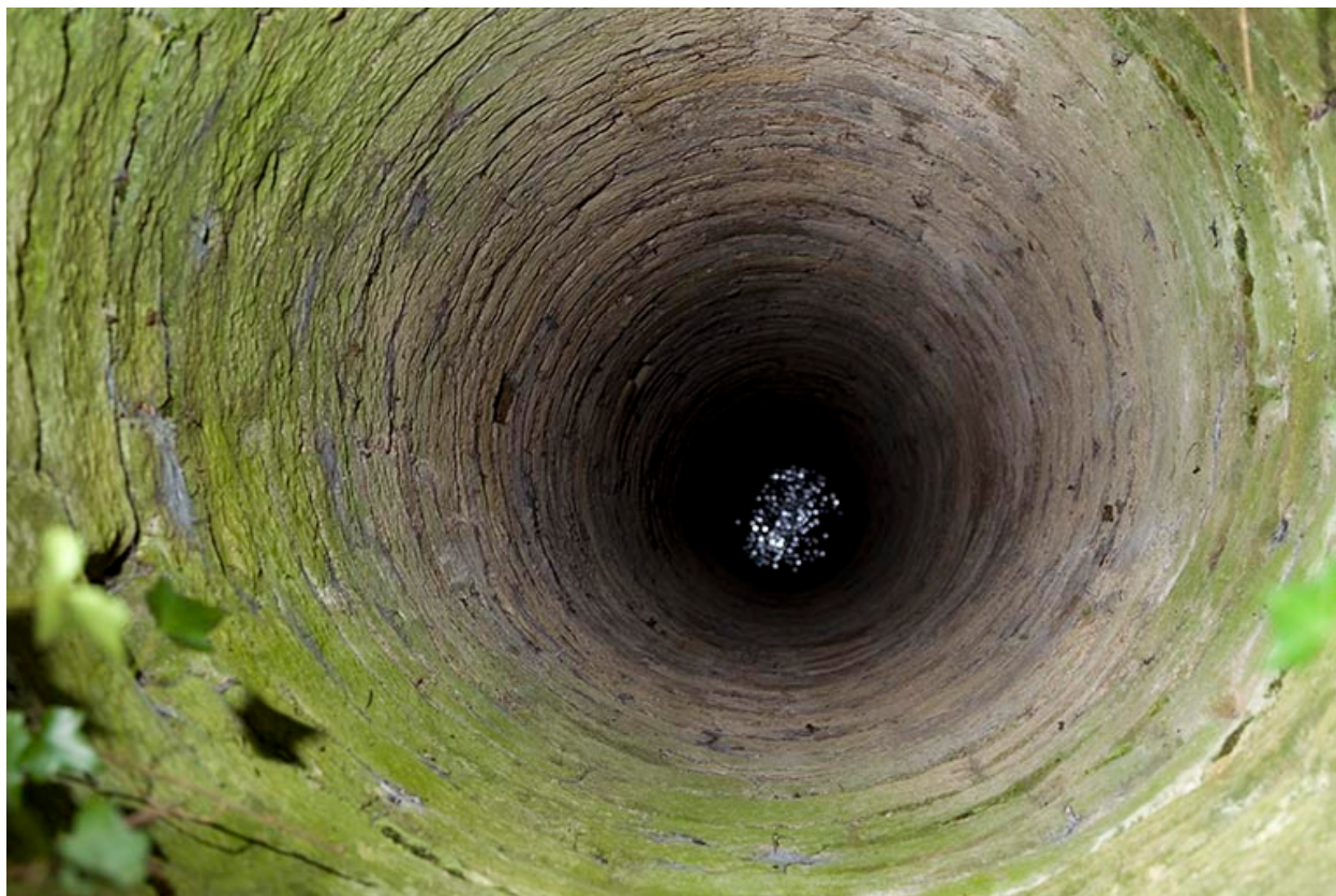
Le trou du puits.
