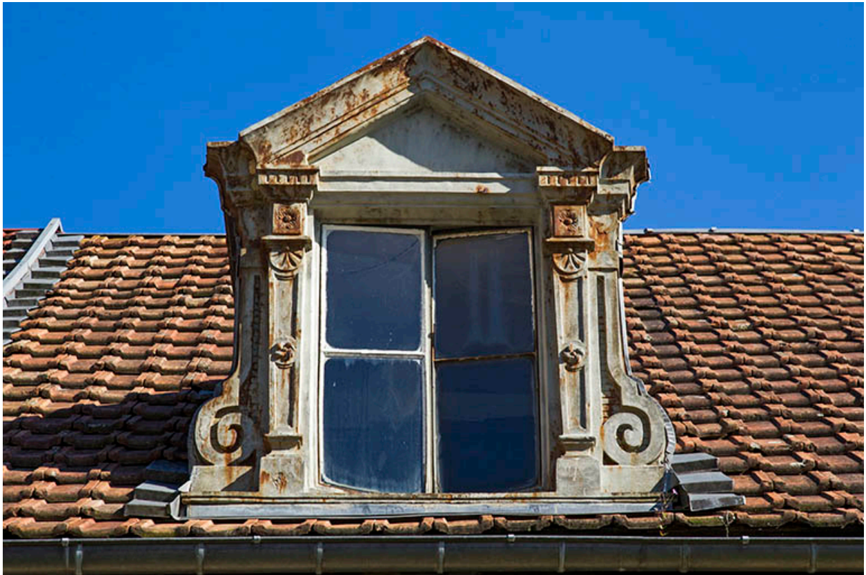
Corps sud, façade antérieure : lucarne.
