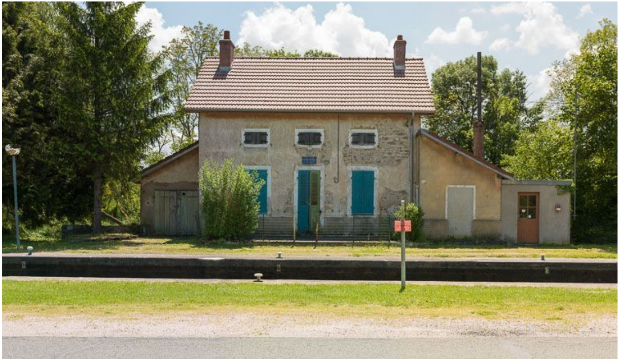
Vue de face de la maison éclusière.
