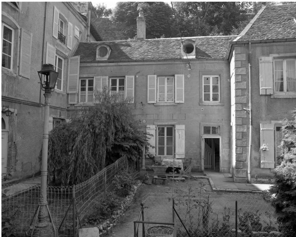
Logement annexe gauche : façade antérieure de face.
