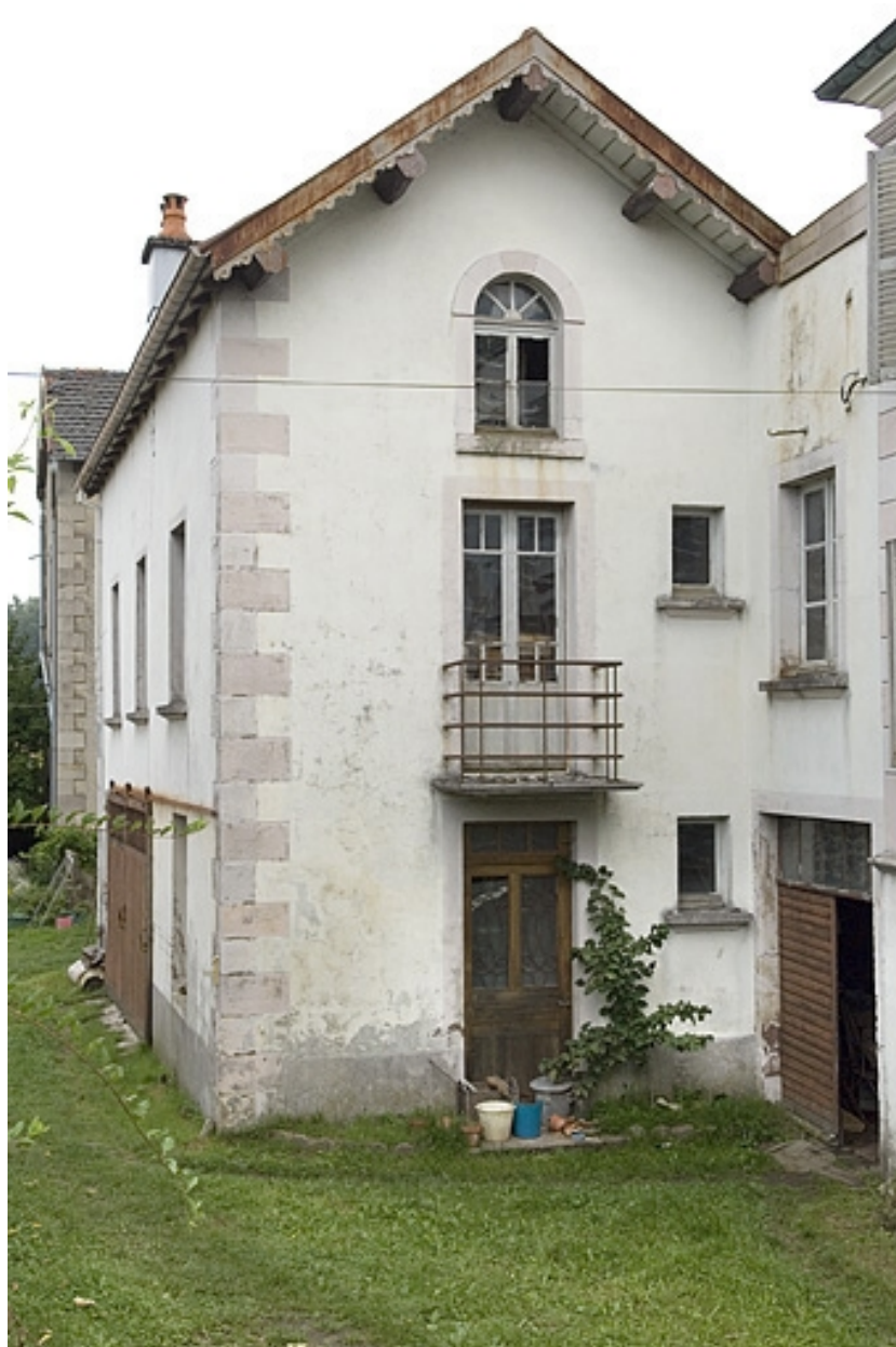
Garage, écurie et logement. Pignon du bâtiment.
