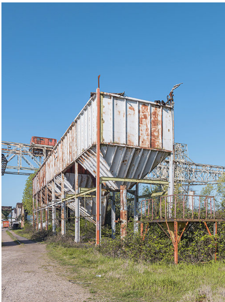
Trémies le long du quai.
