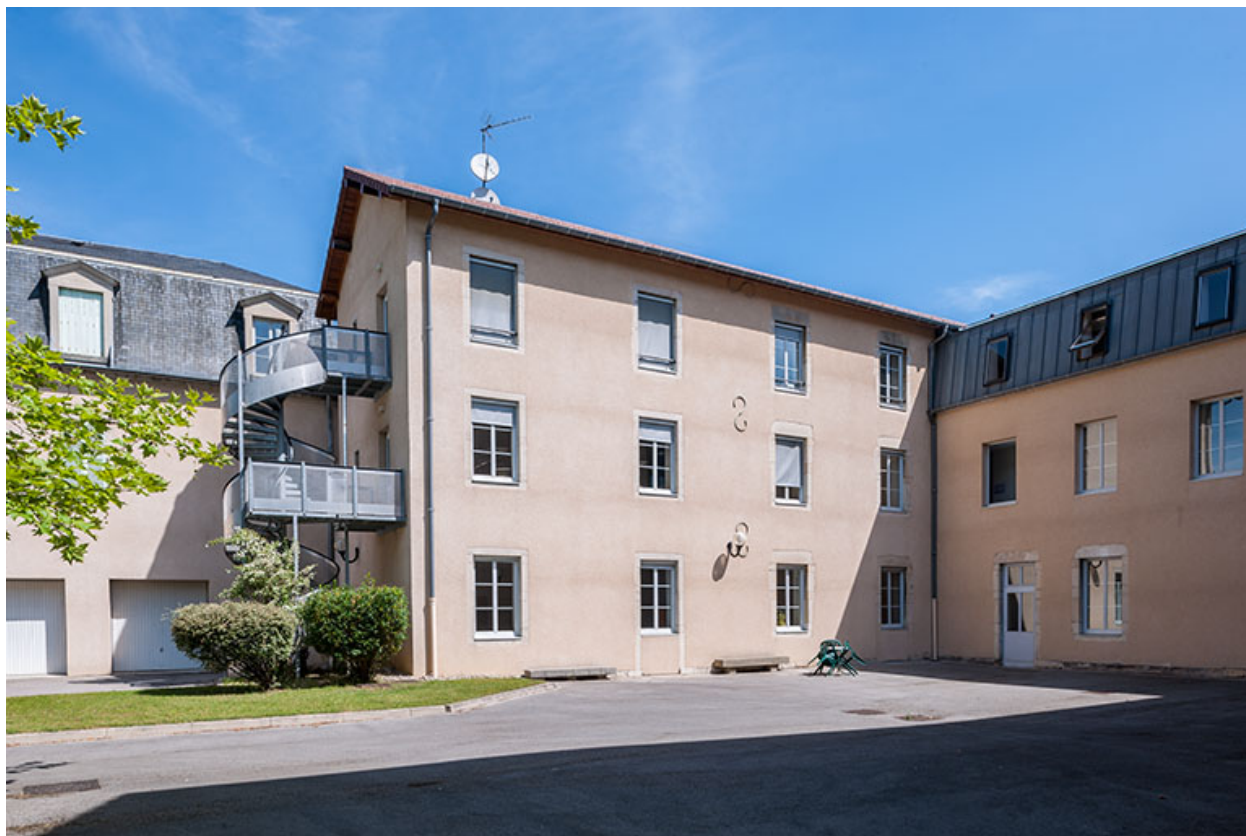
Façades postérieures des bâtiments administration.
