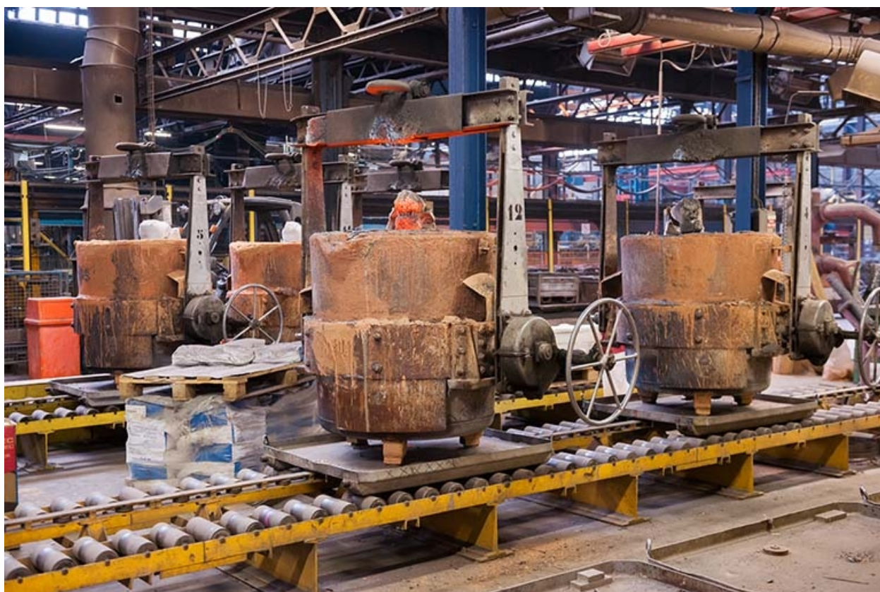
Poches de coulée avant réfection (2).
