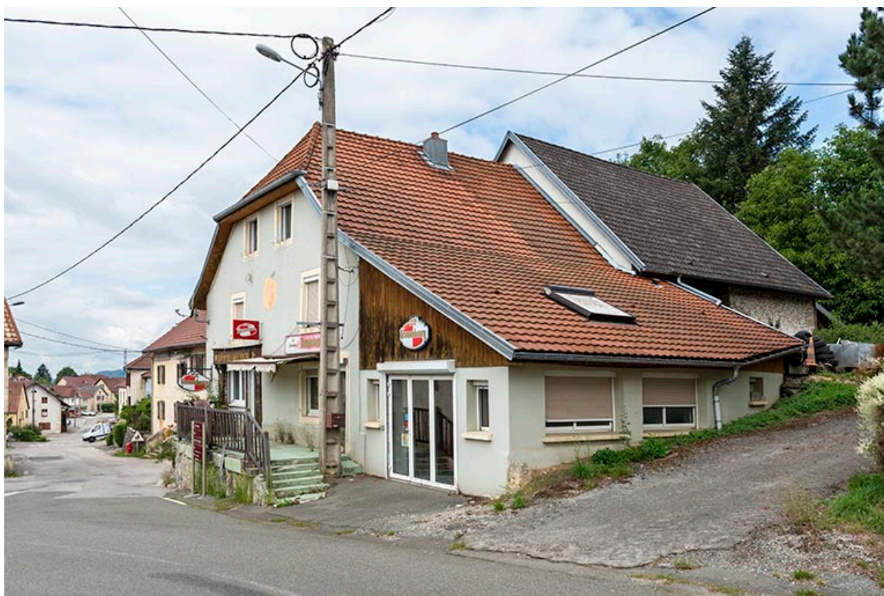
Façades antérieure et latérale droite.
