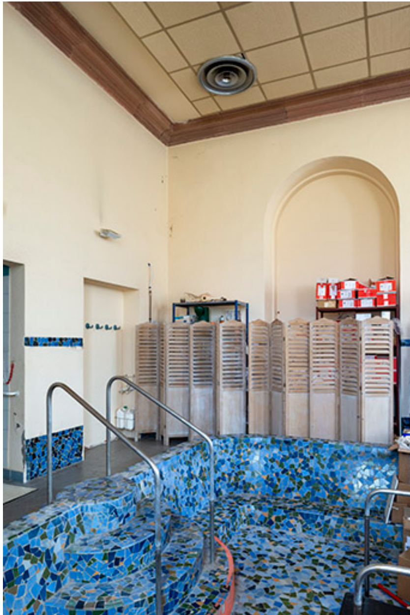
Piscine à l'emplacement du Bain des Dames, vue en direction du nord-est.
