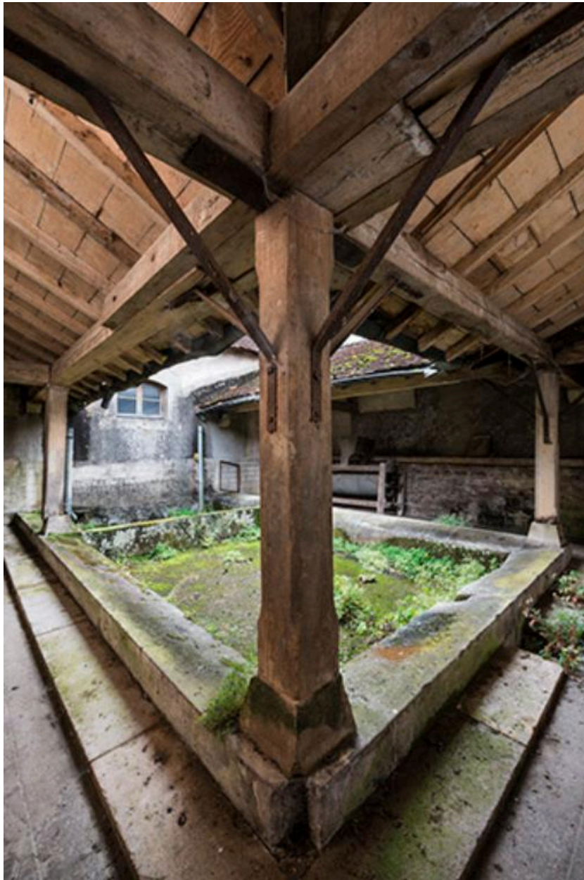
Vue depuis un angle de la galerie couverte du lavoir "La Bichette".
