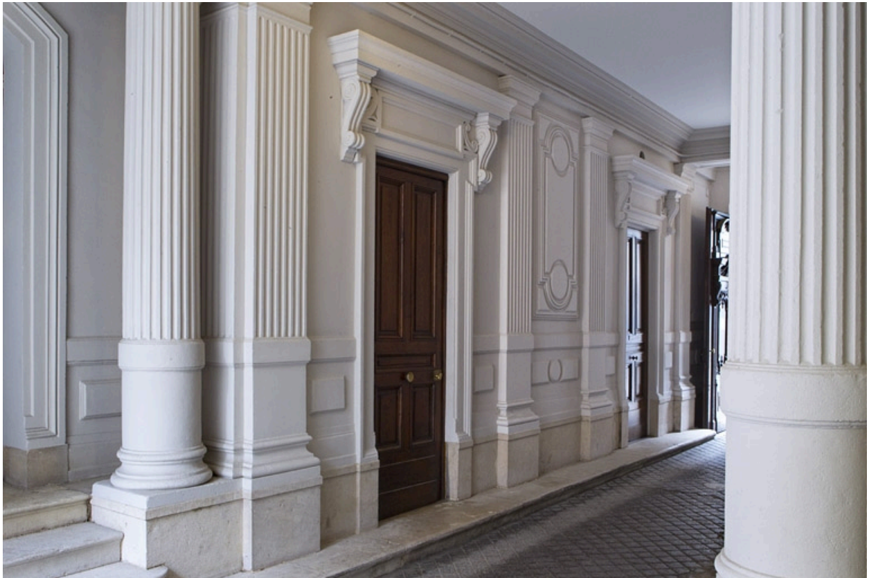
Passage cocher : détail du mur droit de trois quarts gauche.
