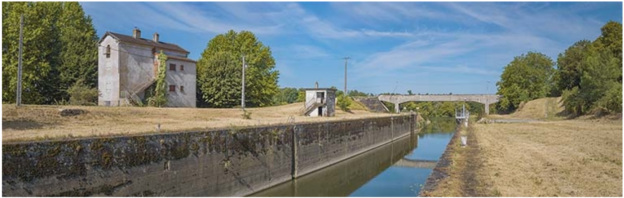
Le sas de l'ancienne écluse.
