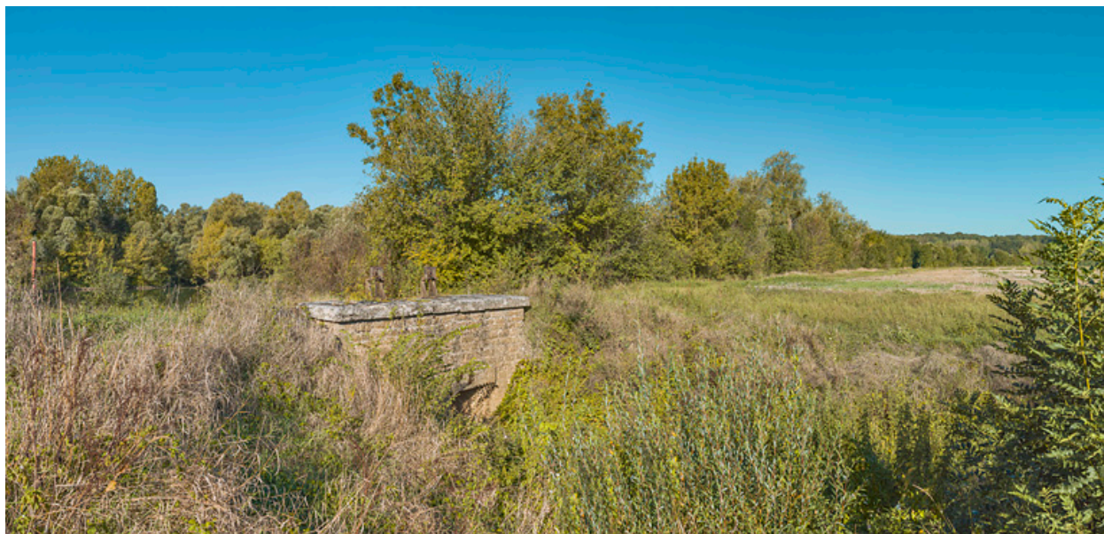
Le ponceau dans son environnement.
