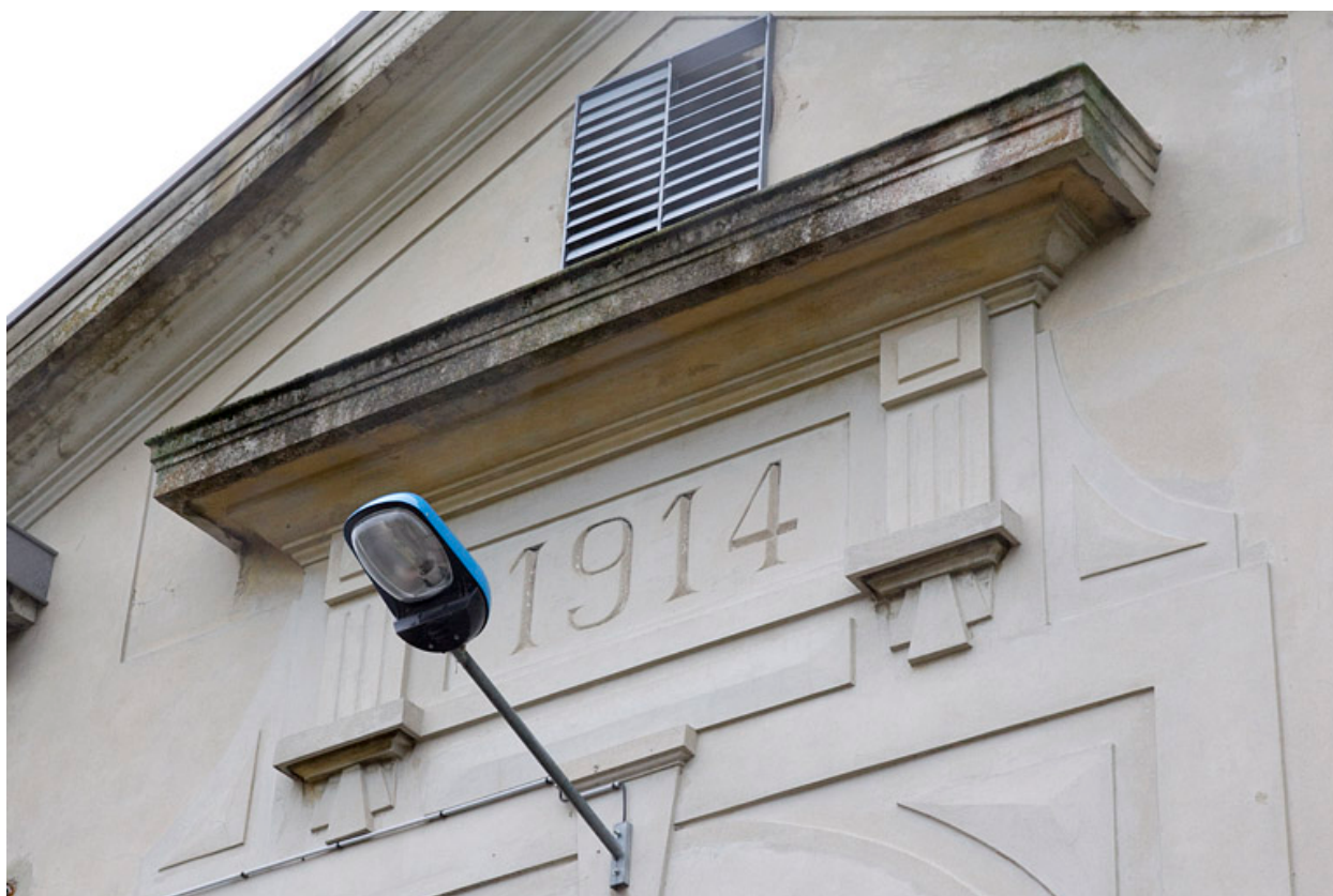
Cartouche de la façade nord.
