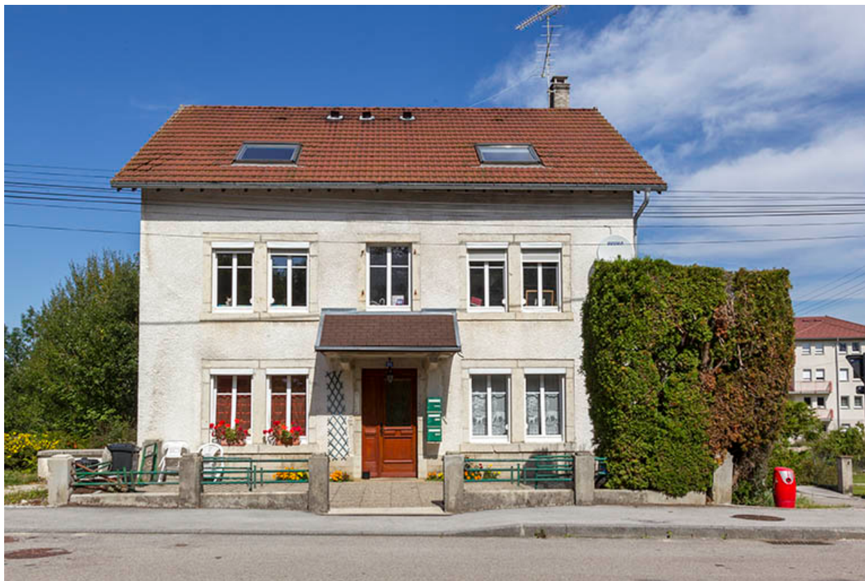
Logement patronal : façade antérieure.
