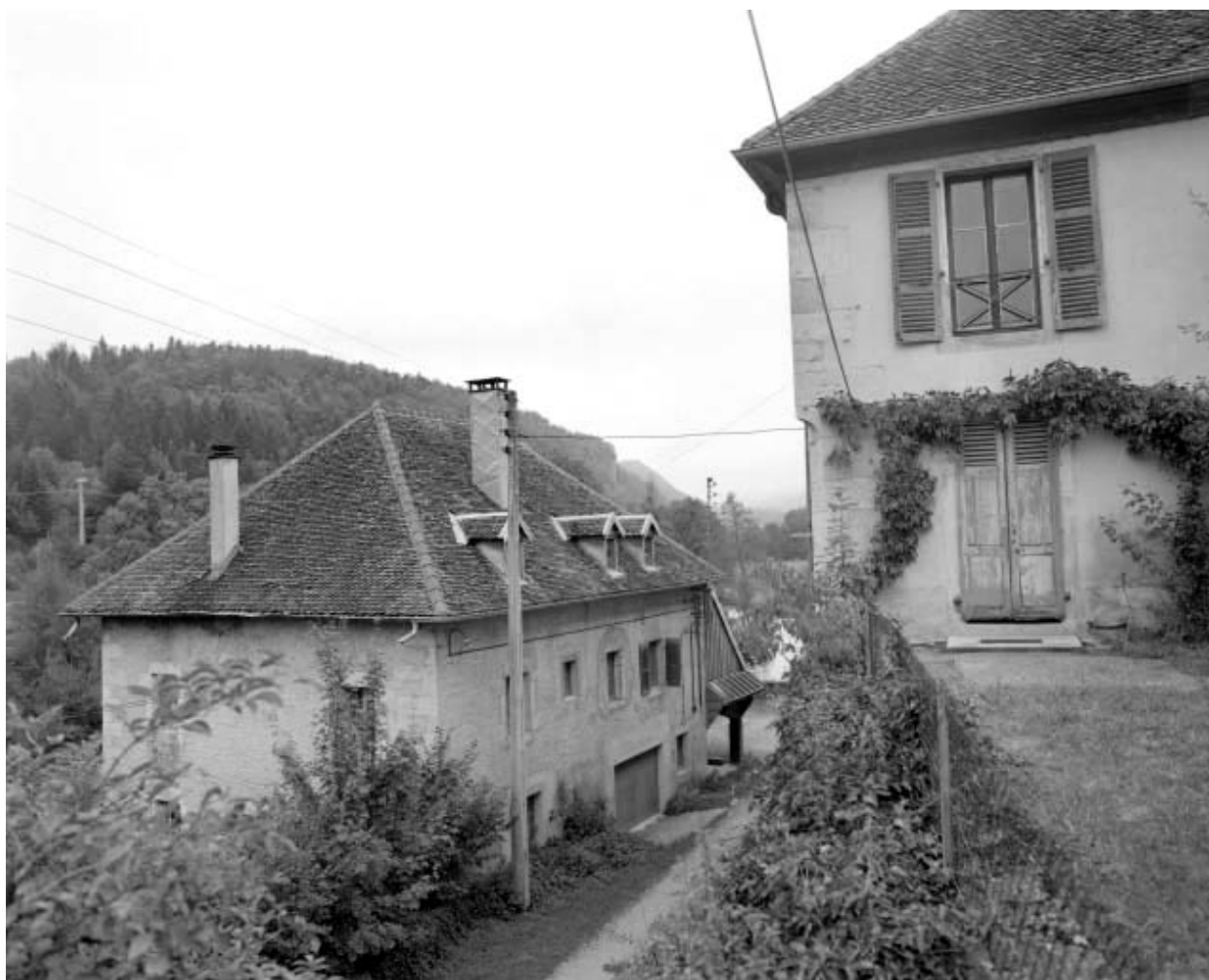
Moulin : façades antérieure et latérale droite.
