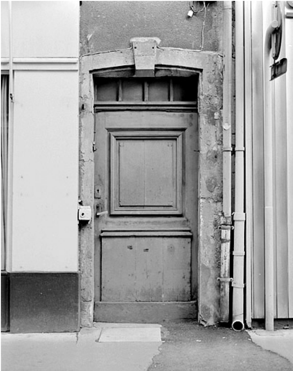
Maison 6, rue du Faubourg. Porte. Dernier quart 18e siècle.
