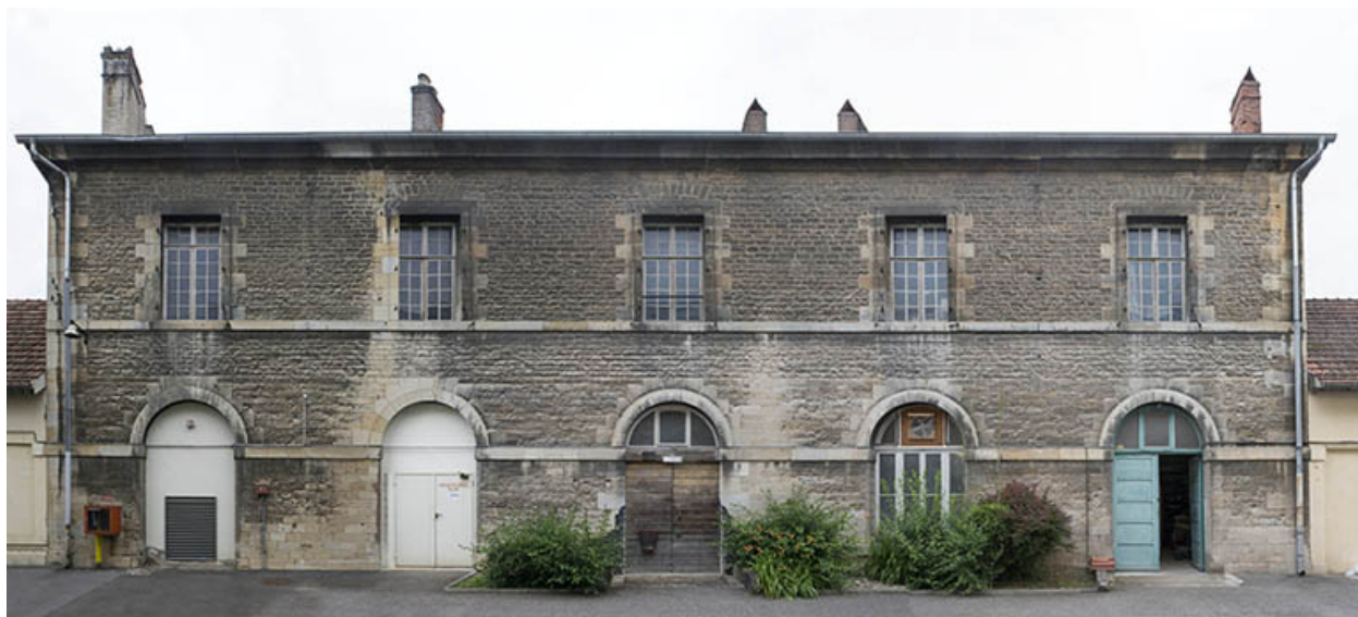
Façade antérieure de l'atelier des agents.
