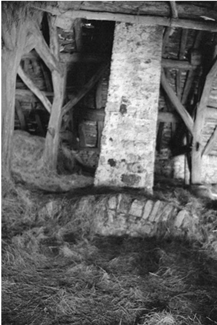
Ferme cadastrée 1960 B 107, située au lieudit La Peyrouse : détail de la charpente d'un toit en laves.
