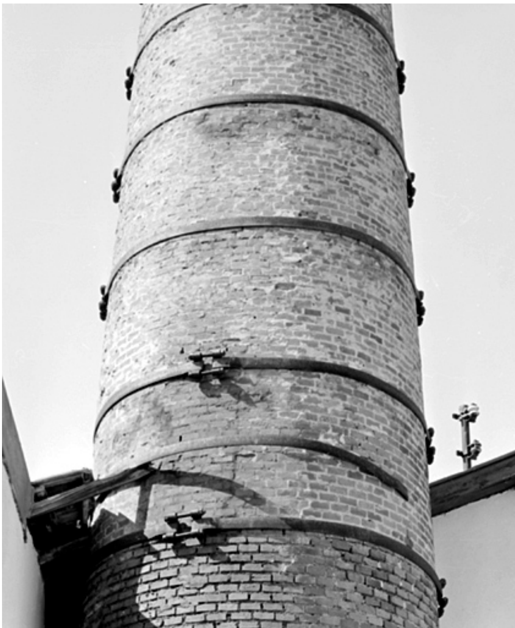
Détail de la cheminée : cerclages métalliques.
