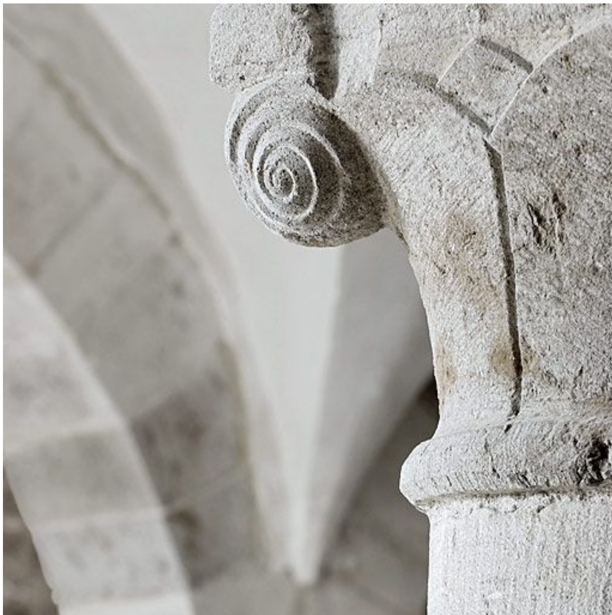
Salle voûtée, détail.
