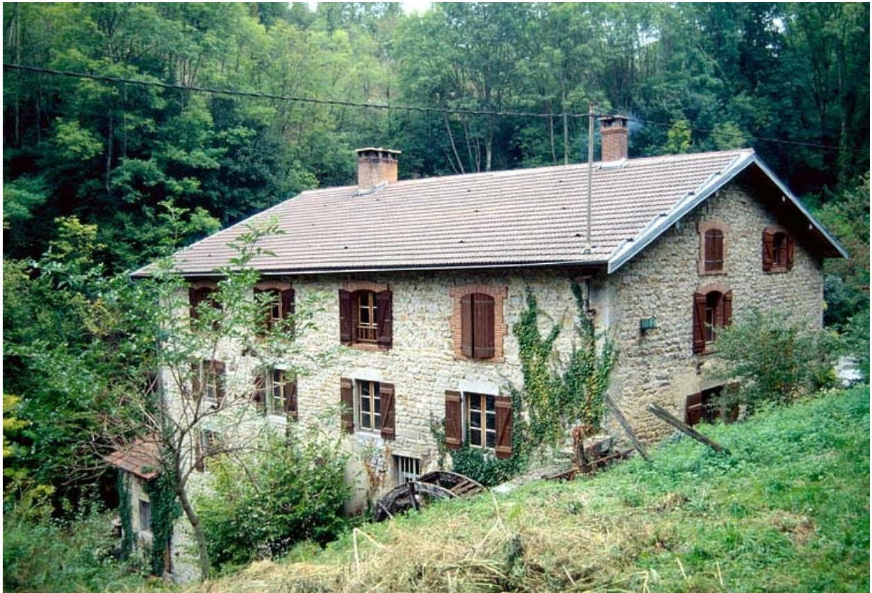
Façades postérieure et latérale gauche.
