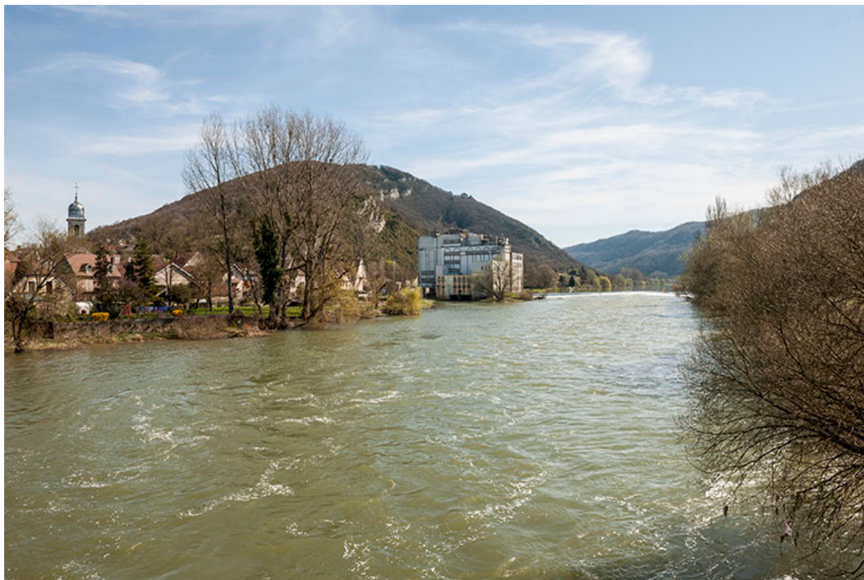
Vue d'ensemble, depuis l'aval.
