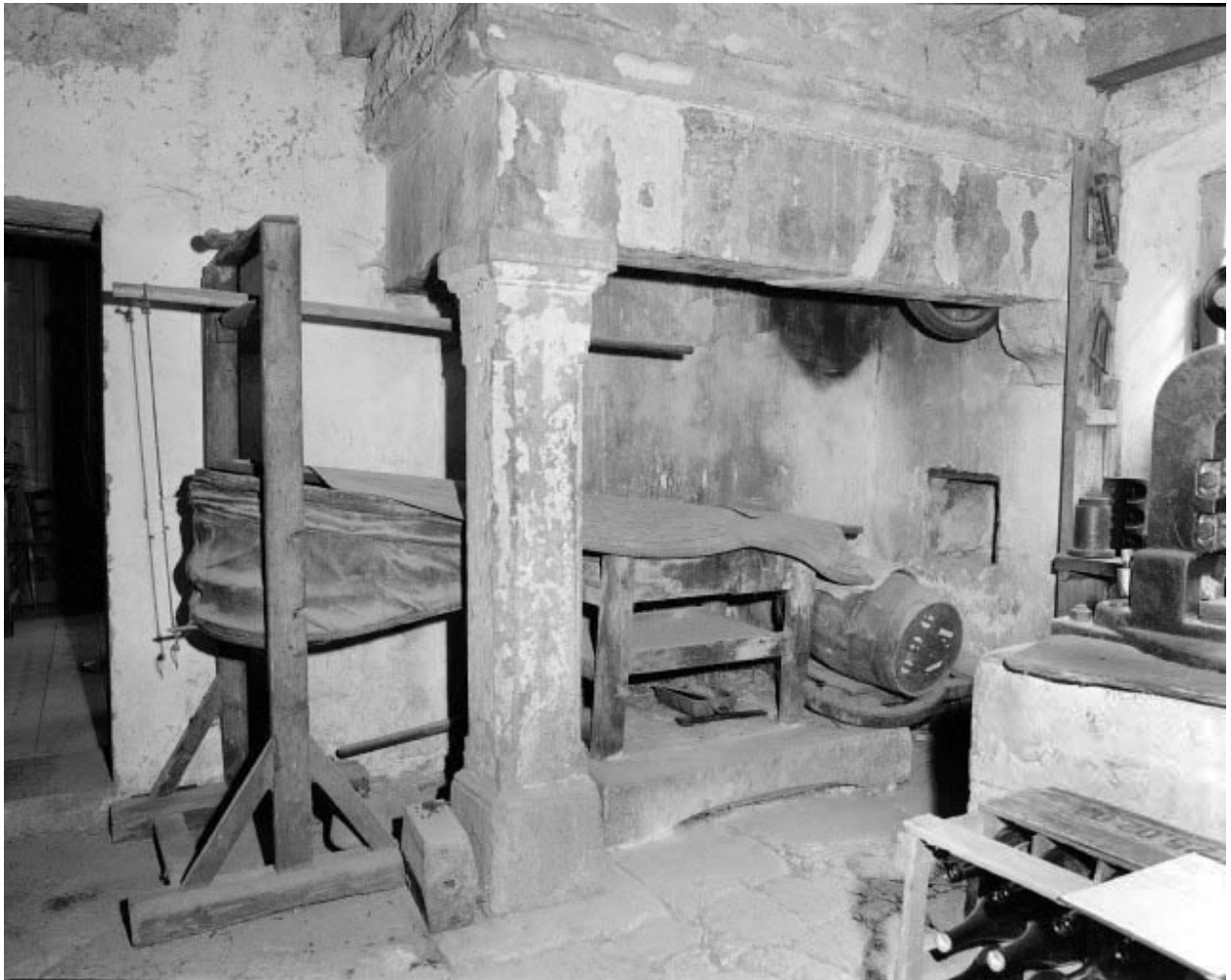
Intérieur : cheminée de la forge, en 1976.
