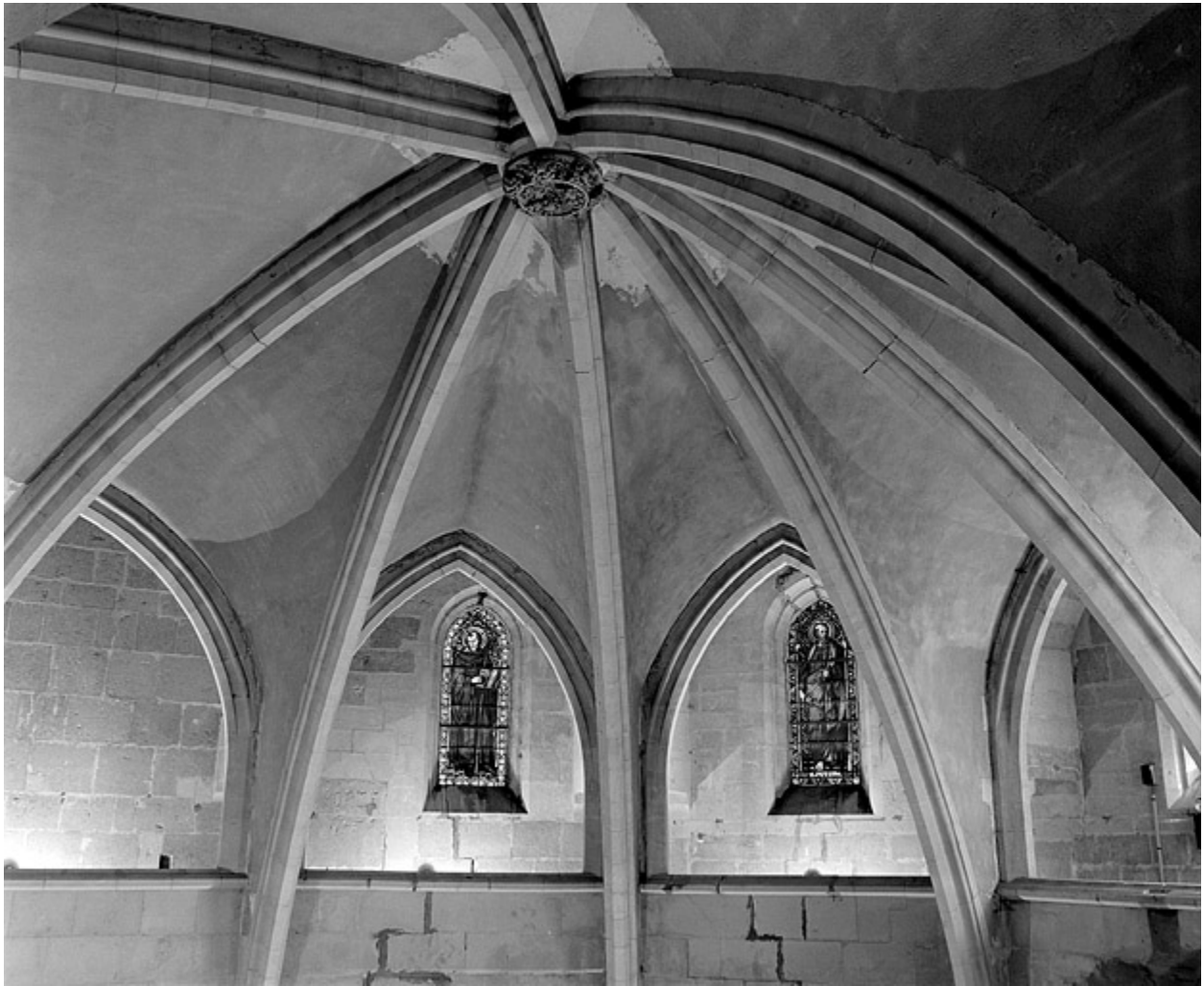
Voûtes de l'abside depuis le sud de la coursière haute (vue horizontale).
