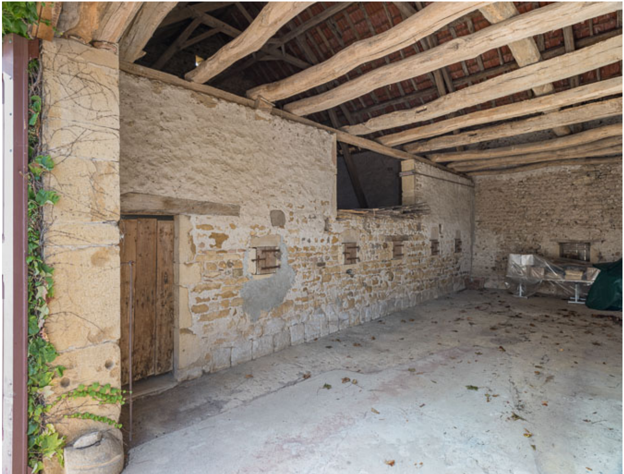
Vue intérieure de la grange. Le mur entre la remise et l'étable est percé de feurons.
