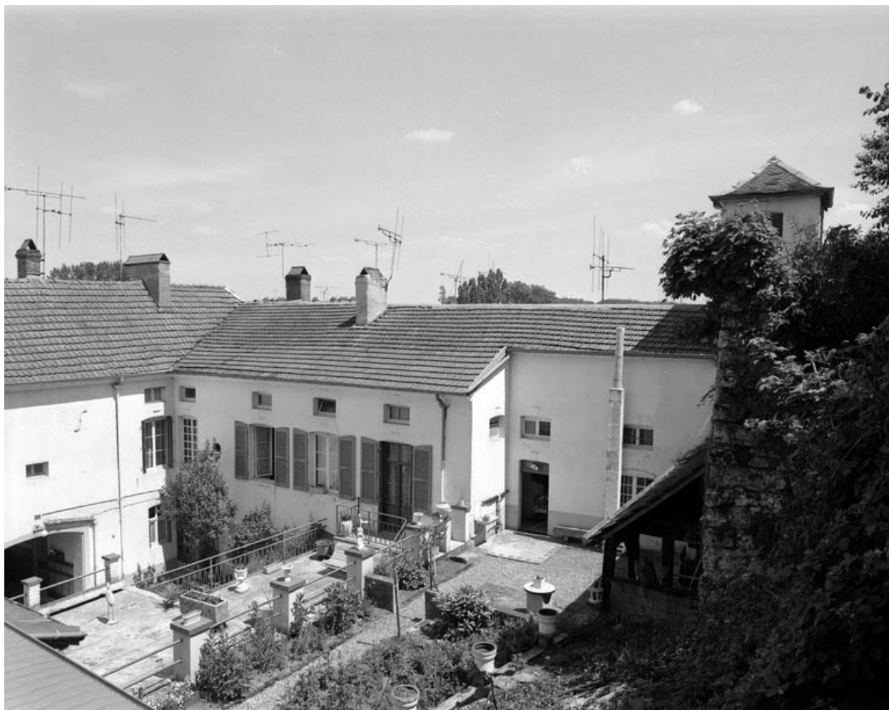
Façade postérieure et aile sur cour.
