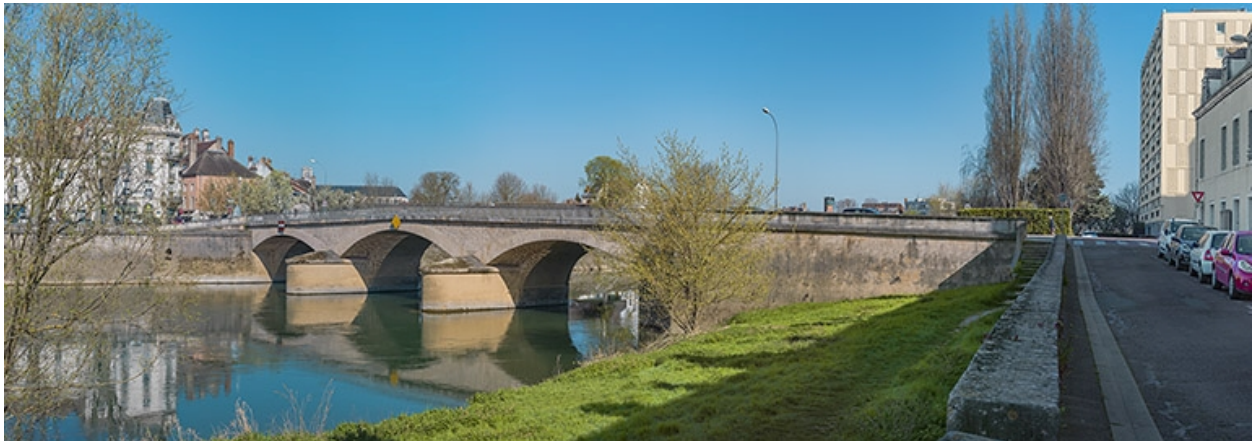
Vue d'ensemble, d'aval.
