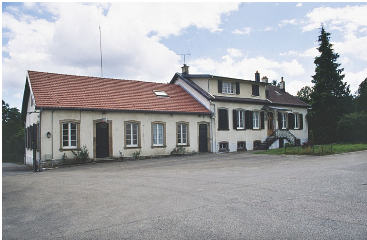
Les bureaux attenants au logement de contremaître.
