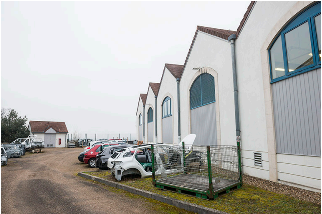
Pignons nord-ouest des ateliers et local des matières dangereuses.
