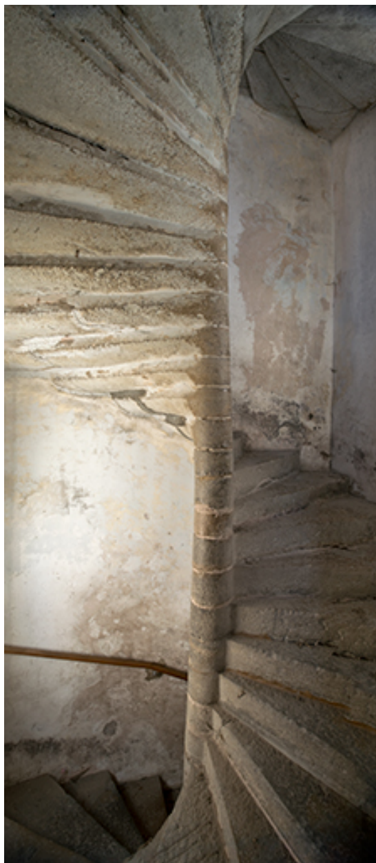
Escalier en vis. Vue depuis le premier étage.
