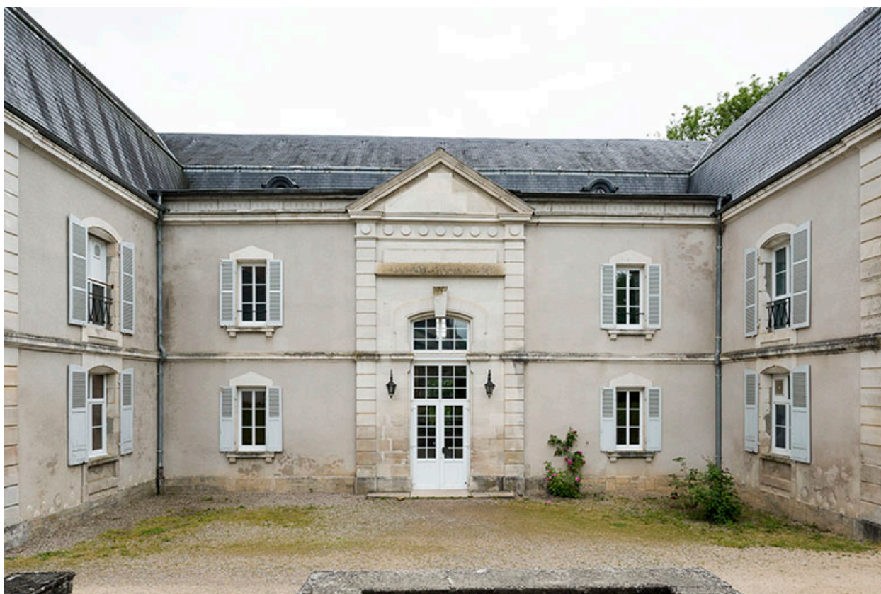
Vue sur la travée centrale
