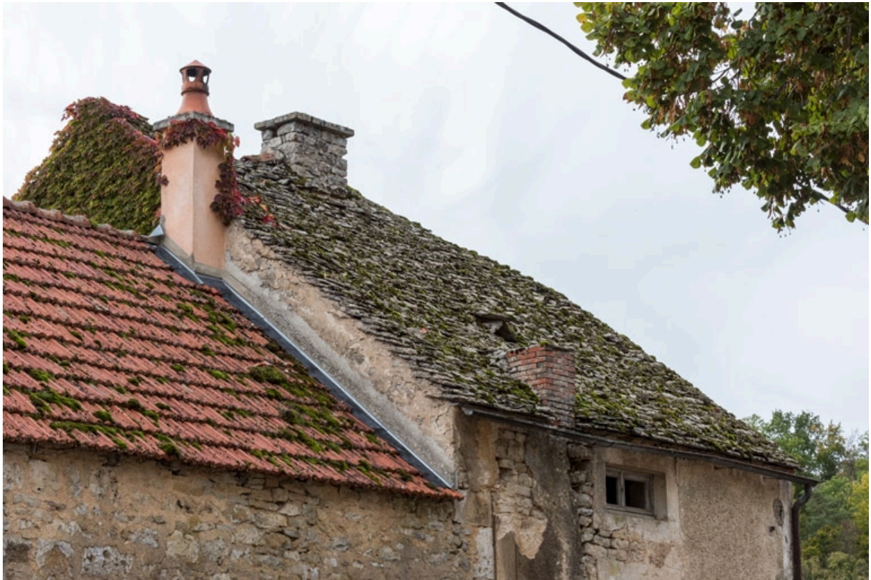
Détail de la toiture depuis le nord-est.
