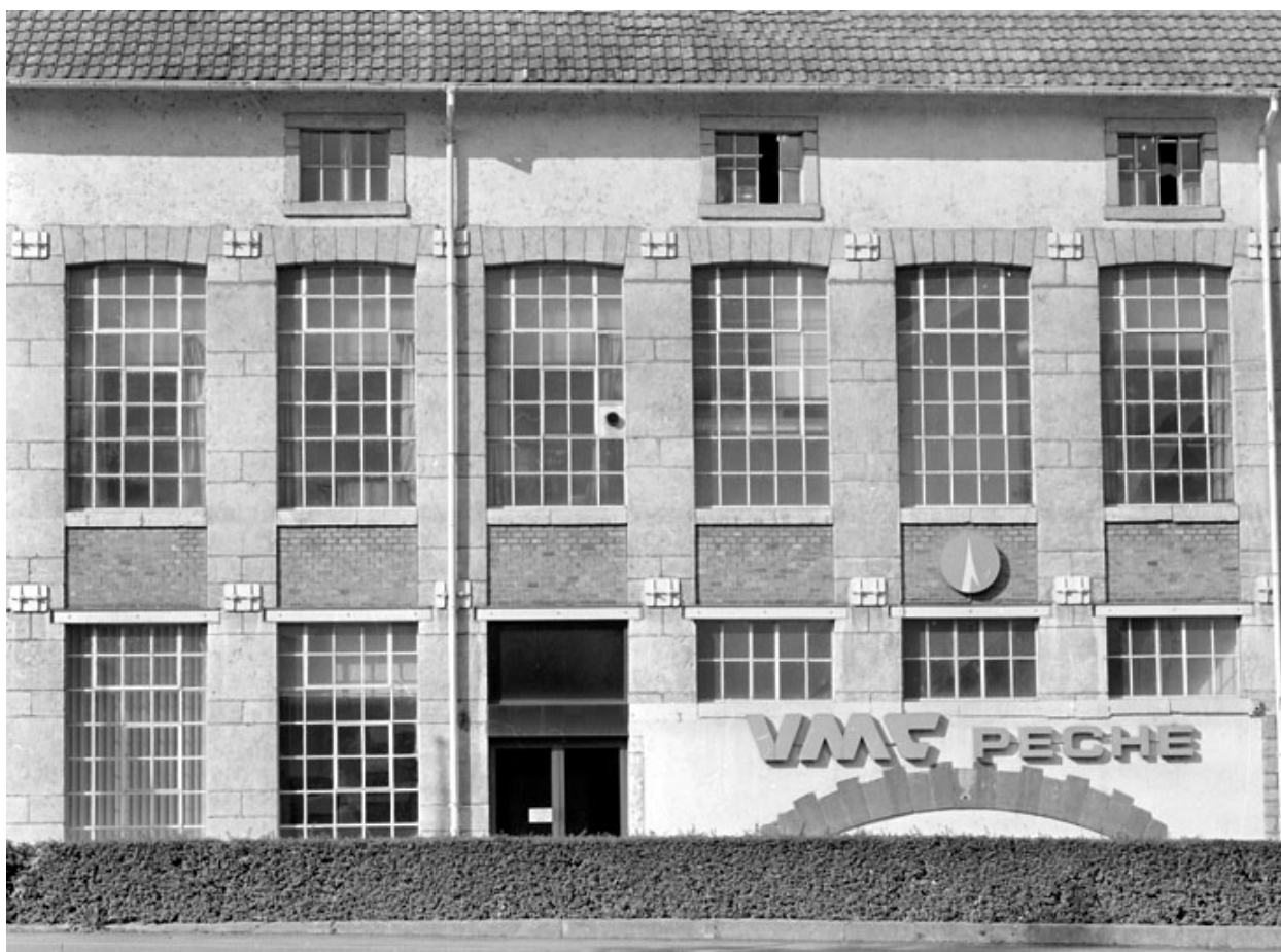
Détail de travées de la façade antérieure.
