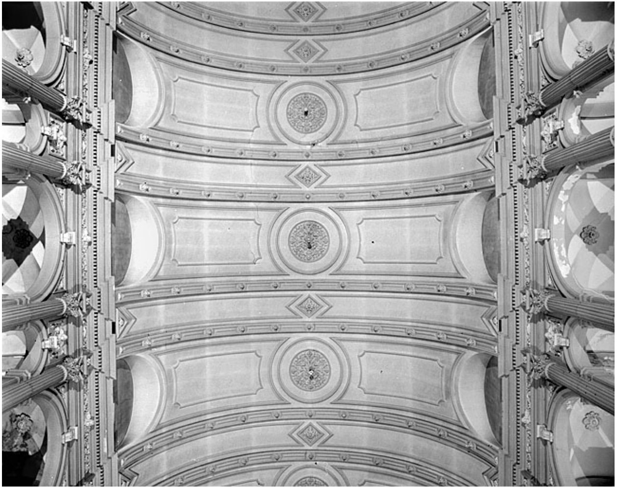
Fausse-voûte de la nef.
