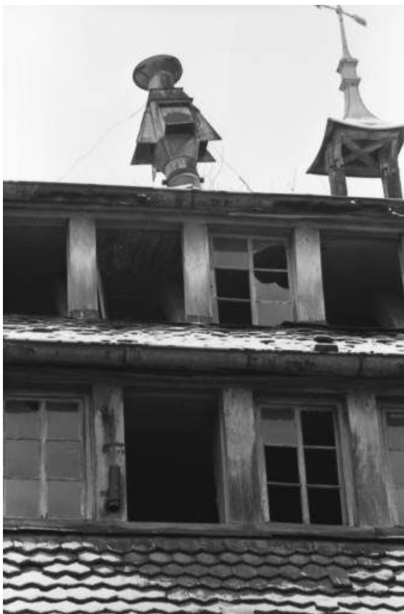
Usine japy, à Badevel, en 1979 : baies des étages de comble de l'atelier d'horlogerie.
