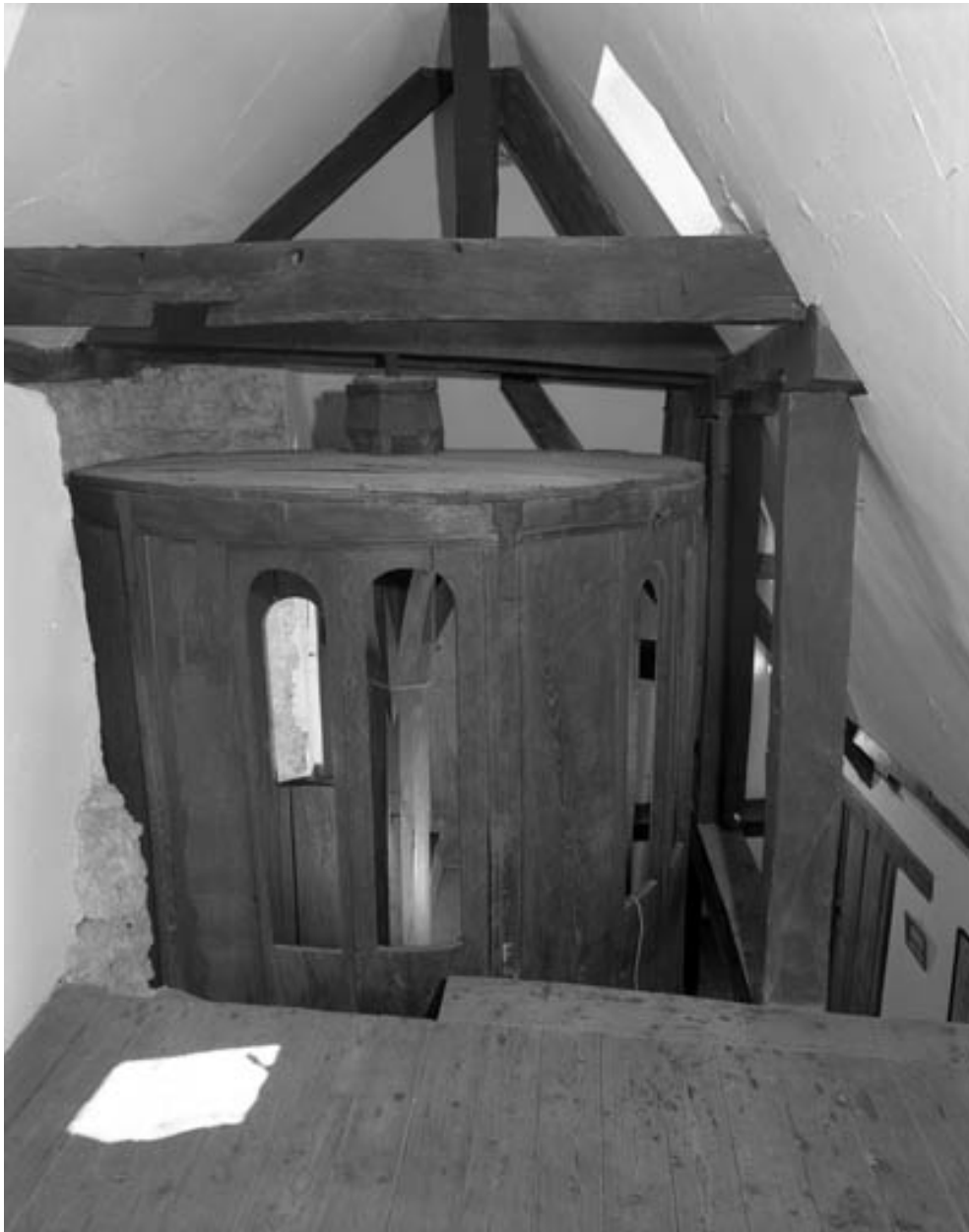
Sommet du cylindre depuis les combles.
