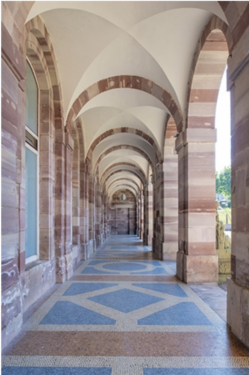
Bâtiment nord dit du Grand Bain, façade sud, galerie.
