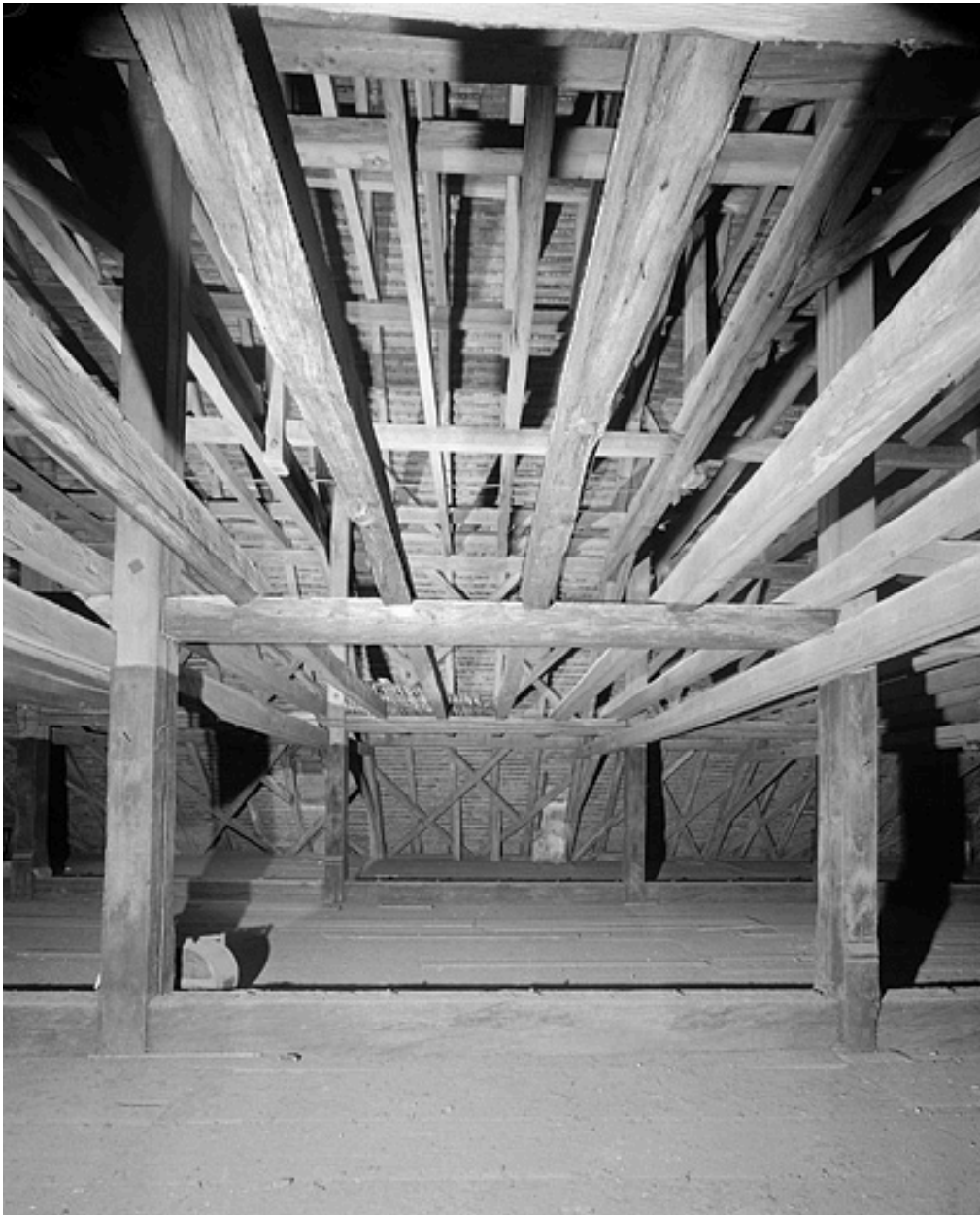
Charpente, vue latérale.
