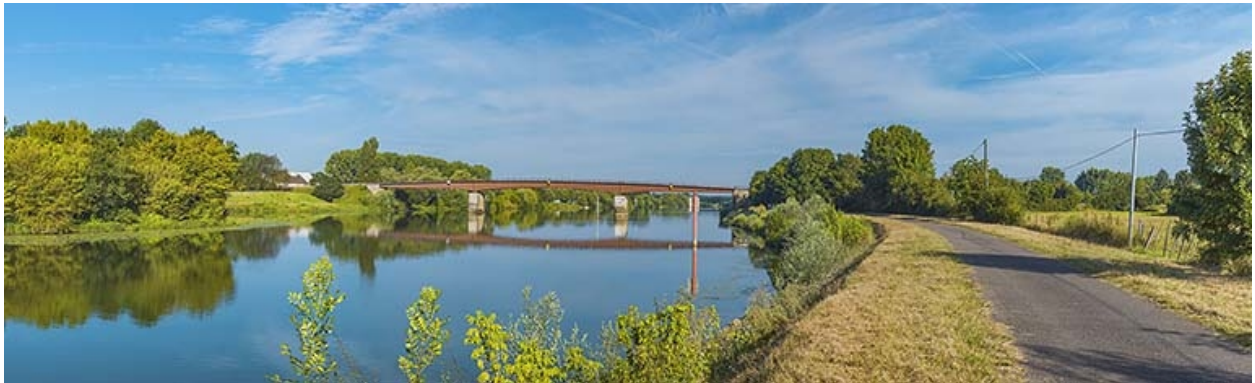
Le pont de Bragny vu d'amont, rive droite.
