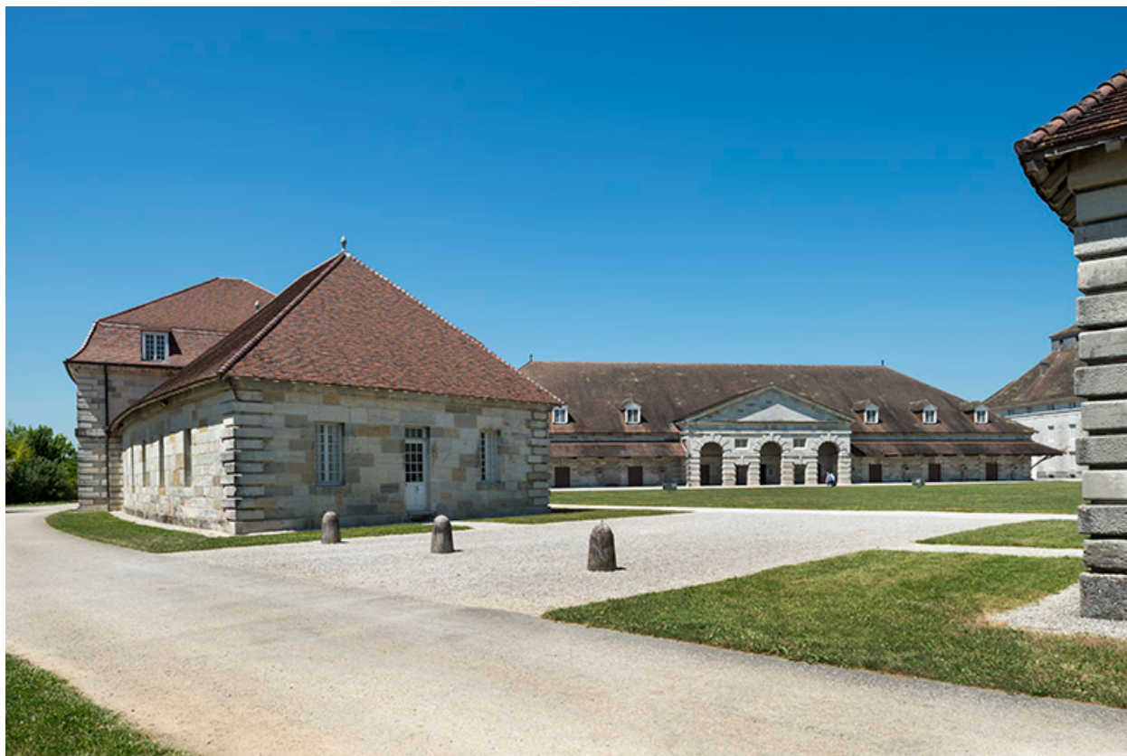
Logement d'ouvriers et berne ouest.
