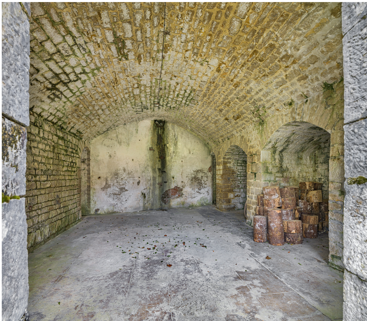
Salles casematées : détail et voûte.
