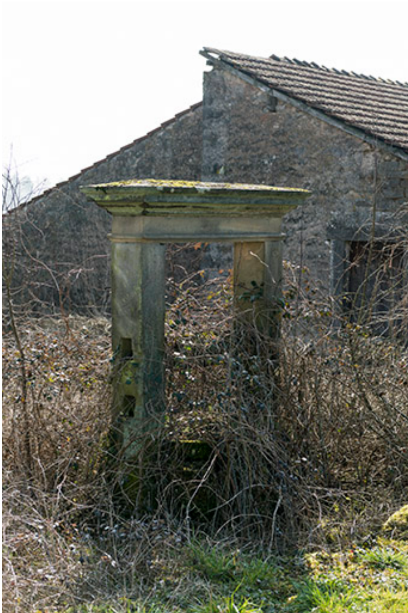
Ancien puits du bourg fortifié.
