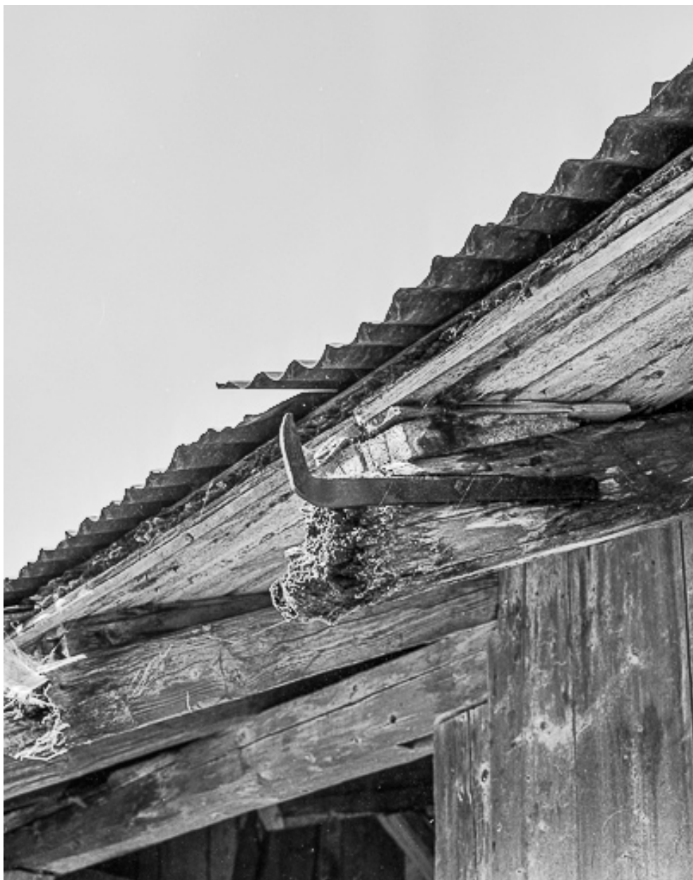
Détail de la couverture.
