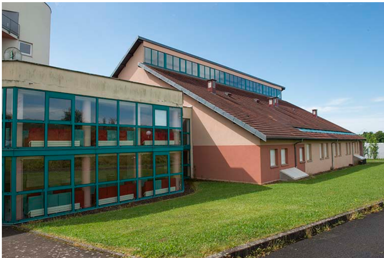
Façades postérieures nord de l'internat sud-ouest.
