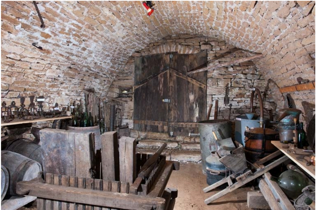
Vue générale de la cave depuis l'entrée.
