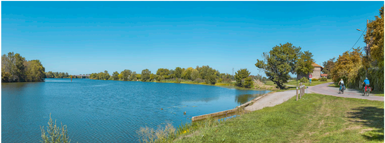
Vue d'ensemble de la cale double.
